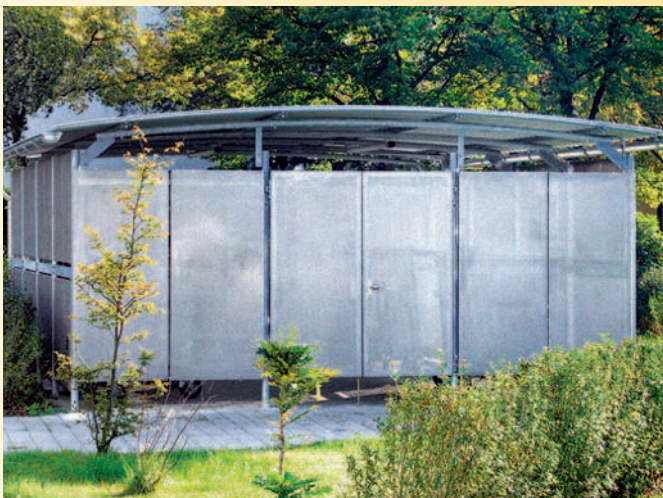
Modul 4 mit Lochblechwänden und Dachrinnen
